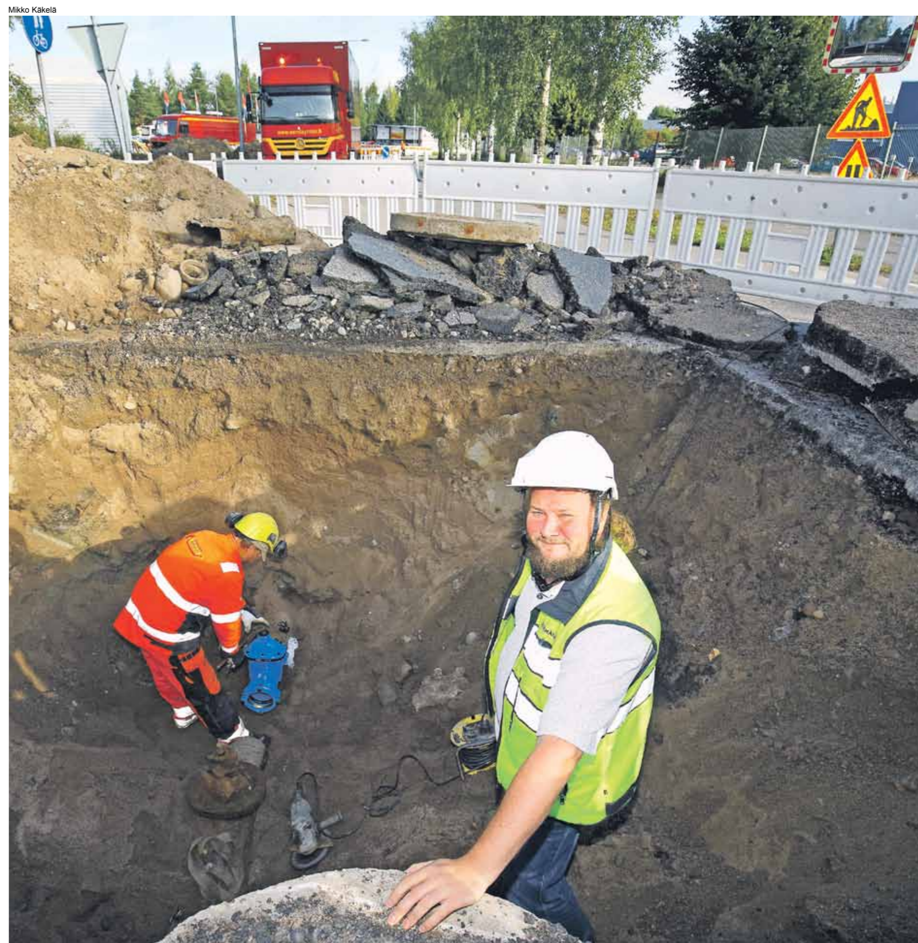
▲ Vuosihuoltosuunnittelija Riku Ylimäki tarkastaa, että suunnitelmat toteutuvat käytännössä myös työmaalla.
