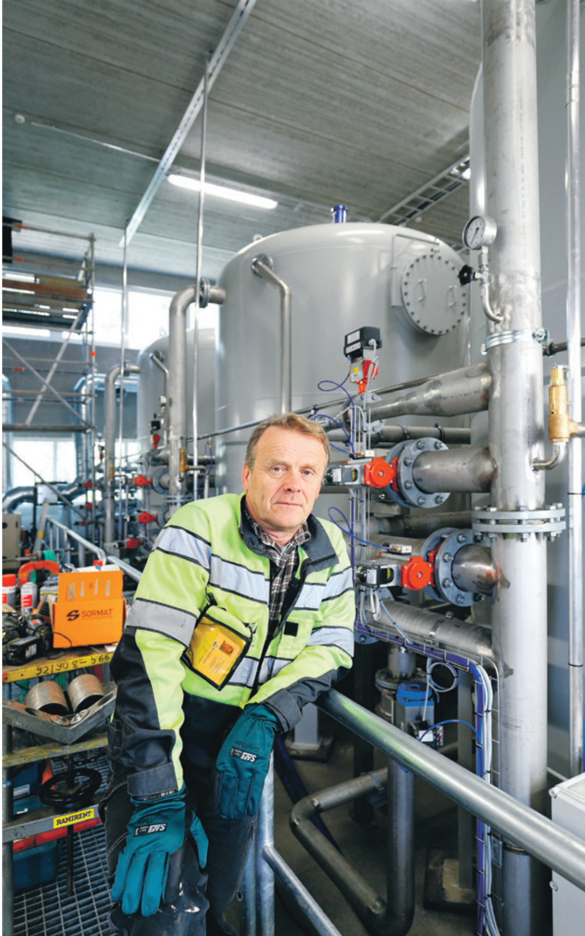
▲ Herajoen vesilaitoksen saneeraus parantaa vedenkäsittelyn toimintavarmuutta sekä laitoksen tuottaman veden laatua, työnjohtaja Reijo Tyvijärvi kertoo.
