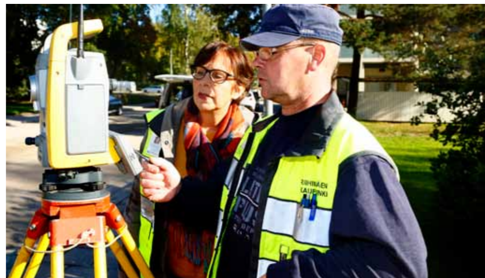
▲ Maastossa mitatut tiedot voidaan siirtää sähköisesti verkkotietojärjestelmään. Kuvassa Anna-Maija Mattila ja Jari Heinonen mittaustyössä.
