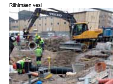
▲ Riihimäen vesi- ja viemäriverkostoja saneerataan eri puolilla kaupunkia.
